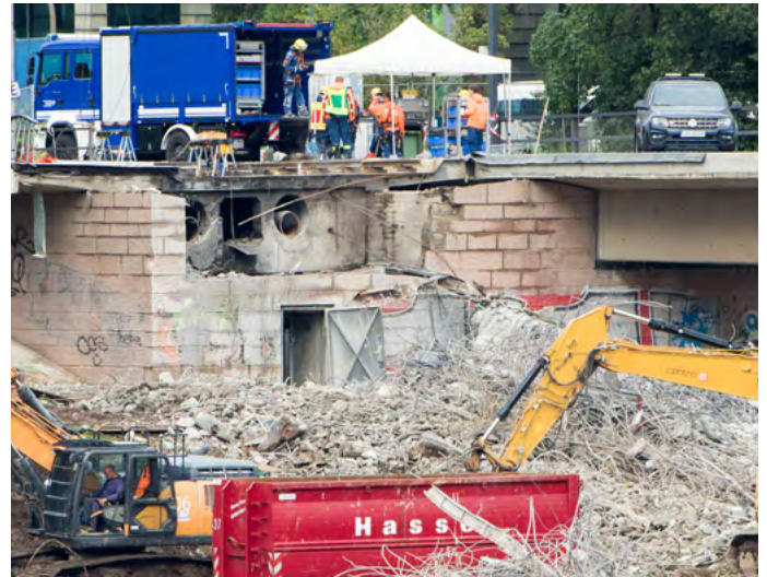
Kurz nach dem Einsturz war auf der rechtselbischen Seite mit dem Abbruch begonnen worden. Foto: Peter Hilbert
