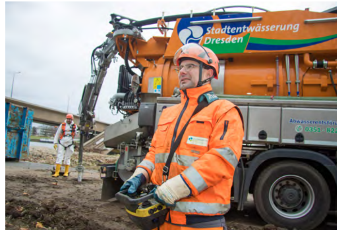
Frank Wilke (vorn) und sein Kollege Chris Volkmann reinigen mit ihrem Saug- und Spülfahrzeug ein erstes Stück eines Auslasskanals an der Carolabrücke.
